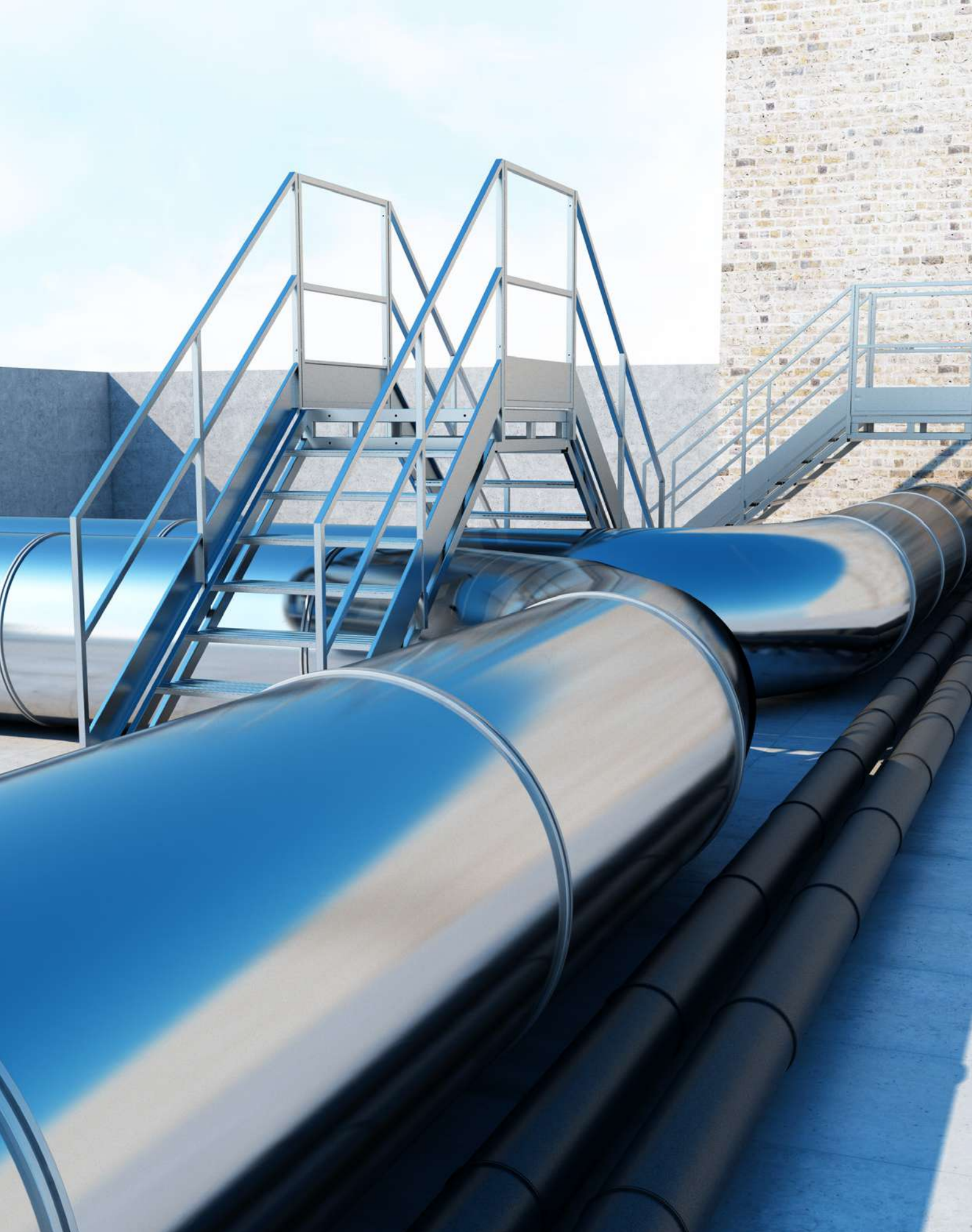
Átjáró gyaloghíd tagolt ipari komplexum fölött
